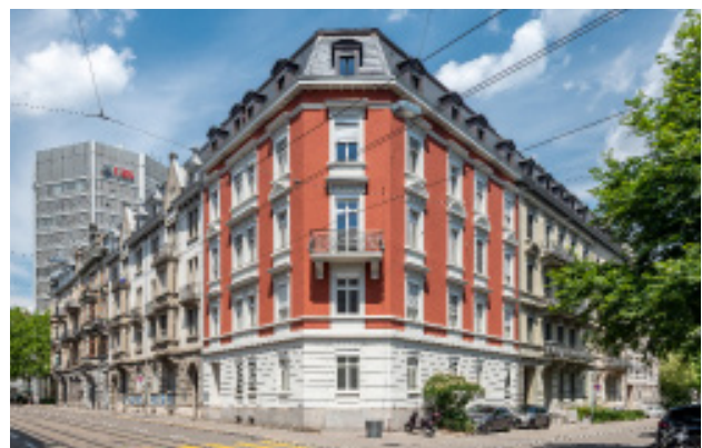
Wohnliegenschaft in Zürich (Zugangsportfolio)
